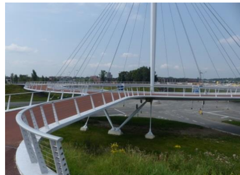
Abb. 2-2 Brückenbauwerk für Radverkehr über einem Knotenpunkt (Heuvenring, Eindhoven, Foto PGV-Alrutz)
